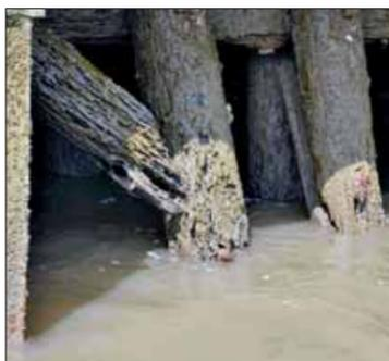
Bei Niedrigwasser waren bereits 2018 deutliche Holzschäden an der wasserseitigen Pfahlreihe zu erkennen.
