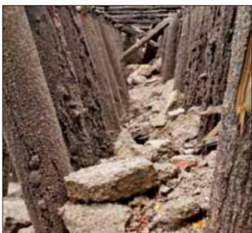
... und schräg gerammte Stützpfähle der Unterkonstruktion
