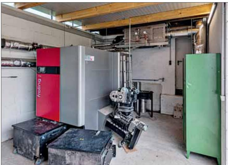
Der Hackschnitzelkessel von Fröling wurde mit zwei elektrostatischen Filtern ausgerüstet. Rost- und Filteraschen werden getrennt erfasst.
