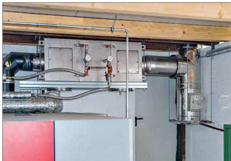
Die zur Wärmerückgewinnung aus den Rauchgasen installierte „Turbu-Flex S-300 Box“ ist horizontal im Abgasweg installiert. Die Kesselrücklaufanhebung bringt 5 bis 6 K bzw. die Anhebung der Wassertemperatur um 8 bis 10 %.
