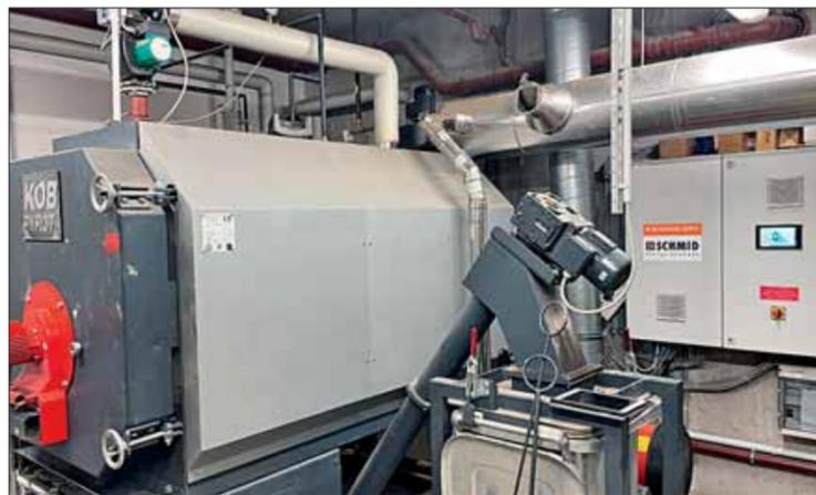
Der KÖB-Kessel wurde durch Schmid mit einer neuen Steuerung modernisiert.
