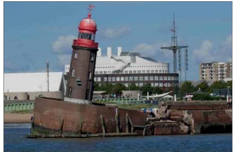
Nordmole in Bremerhaven mit dem mittlerweile abgetragenen Leuchtturm nach dem Absacken des hölzernen Unterbaus im August 2022
