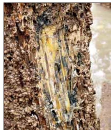
Links Detail eines aktiven Bohrmoschelbefalls im verbliebenen Holz, rechts ein Pfahl mit rund 10 cm Restdurchmesser und Bohrmoschelgängen bis in den inneren Bereich
