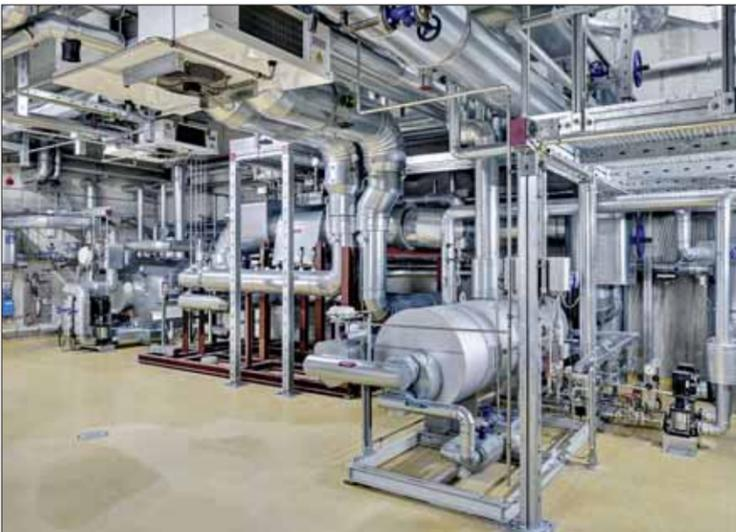
Das von Gammel Engineering konzipierte Energiekonzept inklusive moderner Technik ermöglicht eine flexible Dampfversorgung. Von hier aus werden die Käserei und ein inzwischen 14 km langes Wärmenetz versorgt.
