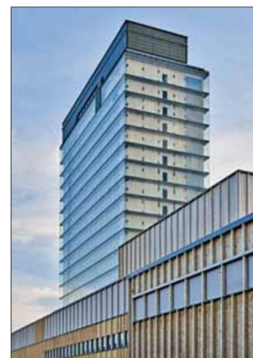
65 m hohe Brettsperrholz-Seitenwände bilden die aussteifenden Scheiben des 19 Geschosse hohen Hotelturms, zwischen die die Holz-Module der Zimmer eingehängt wurden. Auch die umhül- lende Glasfassade ist statisch wirksam.
